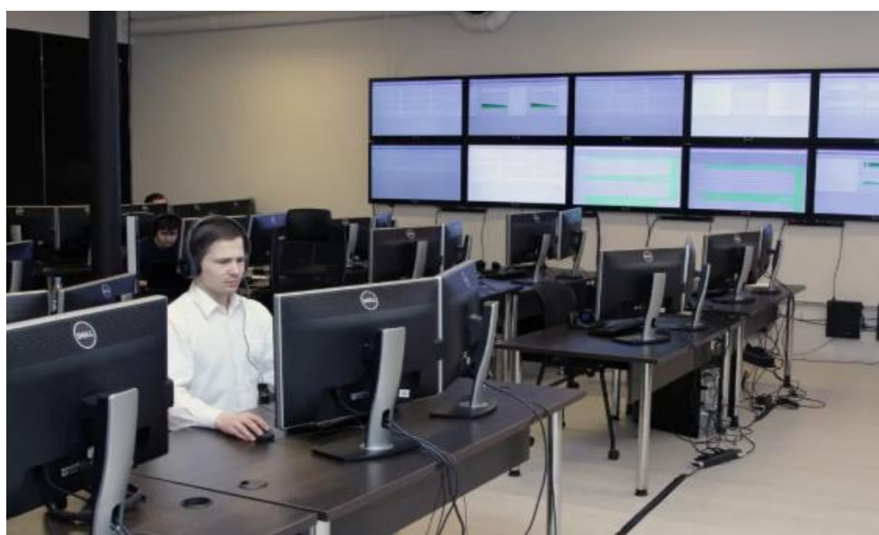
Рис. 7. Ситуационный центр связи
