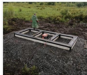
Бетонный фундамент для трансформаторной подстанции
