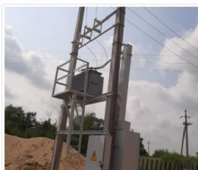
Трансформаторная подстанция
