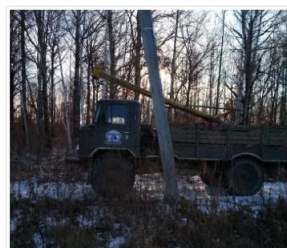
Монтаж опор для частого сектора
