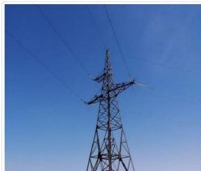
Башенные решётчатые опоры высокого напряжения
