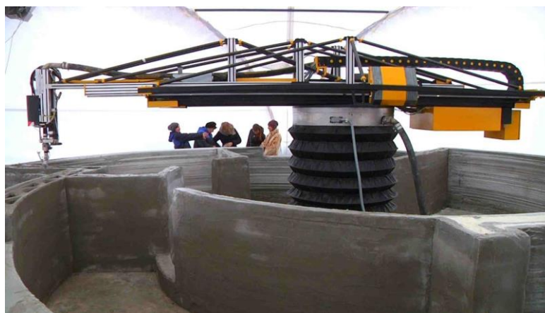
Рисунок 1 – 3d-принтер для строительства домов
