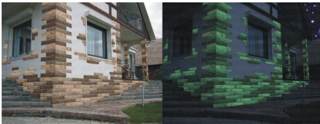
Рисунок 2 - Применение люмобетона для фасада здания
