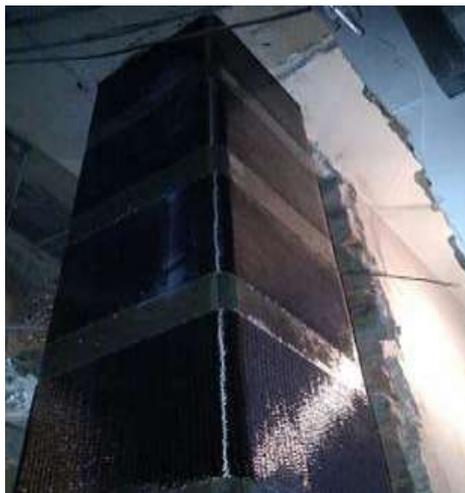
Рисунок 3 - Внешне армированная углеродным волокном железобетонная колонна.
