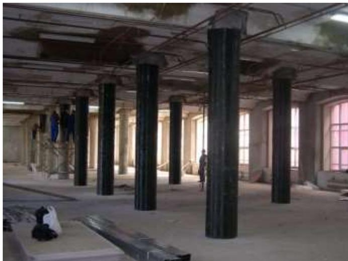
Рисунок 1 - Усиление железобетонных колонн композитным материалом
