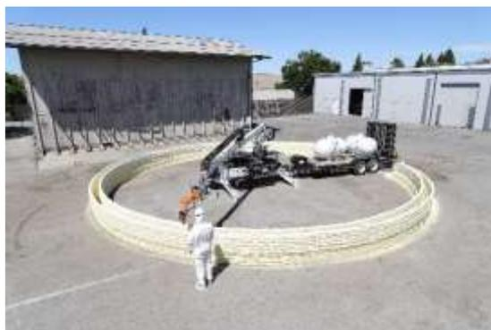
Рисунок 3 – Мобильный 3D-принтер Digital Construction Platform
