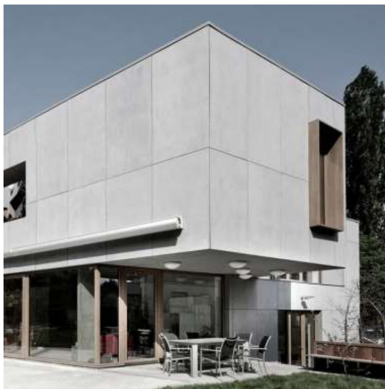
Рисунок 1- Пример облицовки дома целлюлозно-волоконными плитами
