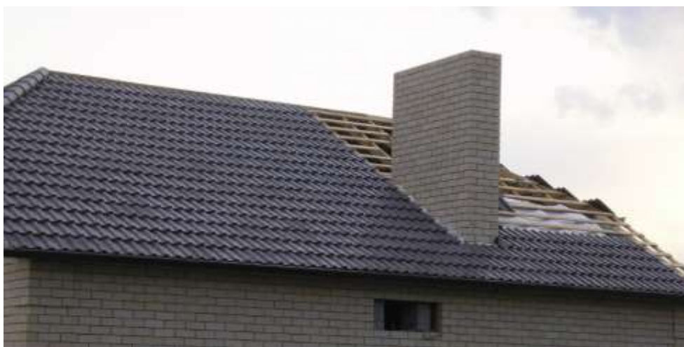
Рисунок 2 – Дом с облицовкой и кровлей из переработанного пластика
