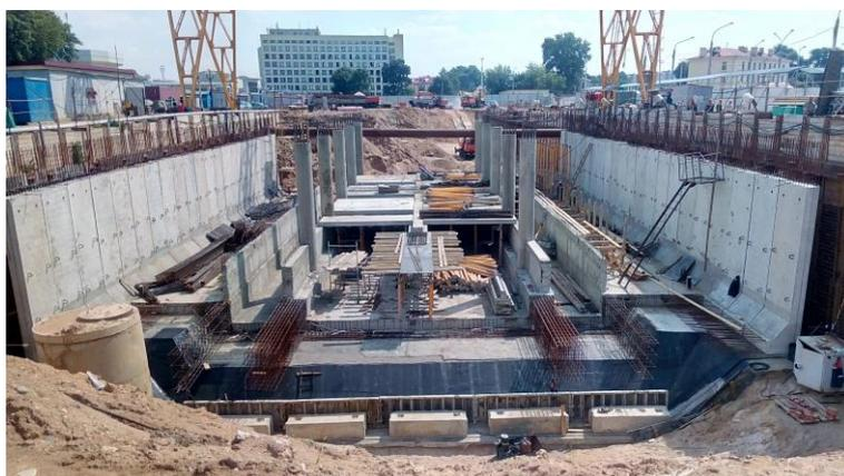
Рисунок 1. Открытый способ строительства тоннелей
