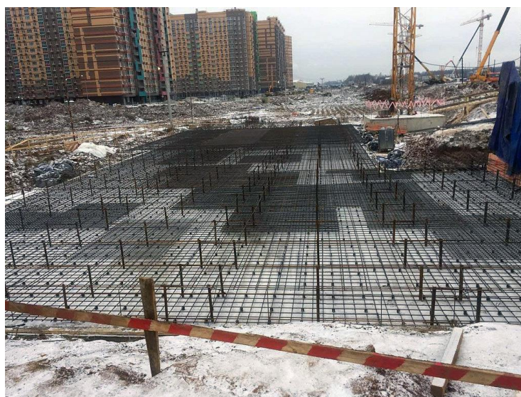
Рисунок 2. Установка арматурных каркасов
