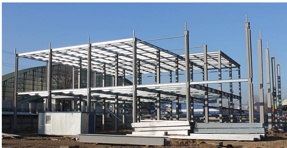
Рисунок 1. Стальные каркасы зданий
