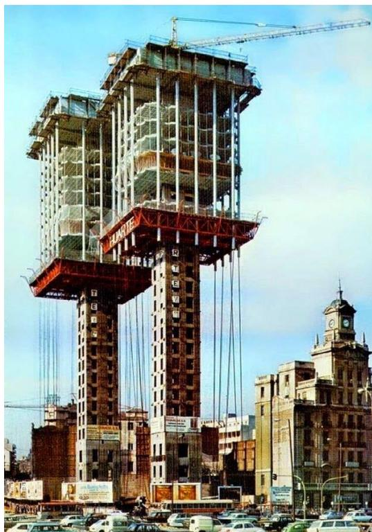
Рисунок 1. Строительство здания технологией Up-down
