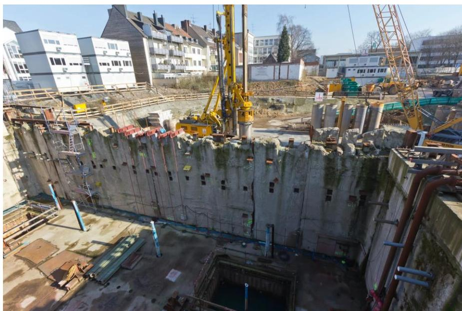
Рисунок 2. Технология "стена в грунте"
