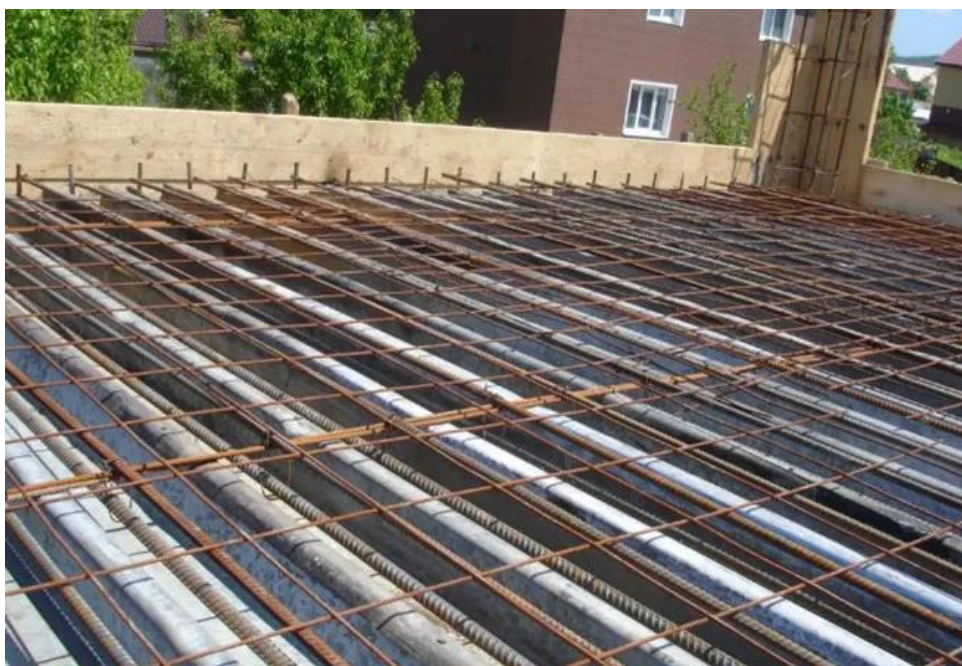
Рисунок 2. Применение настила при заливке фундамента
