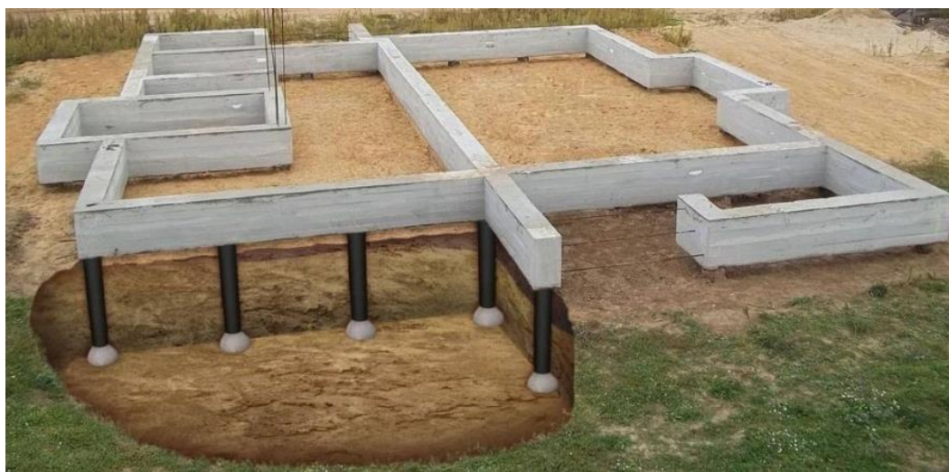
Рисунок 1. Свайно-ростверковый фундамент
